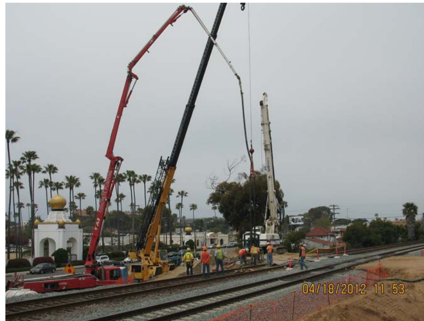
Concrete pour for bridge foundations
